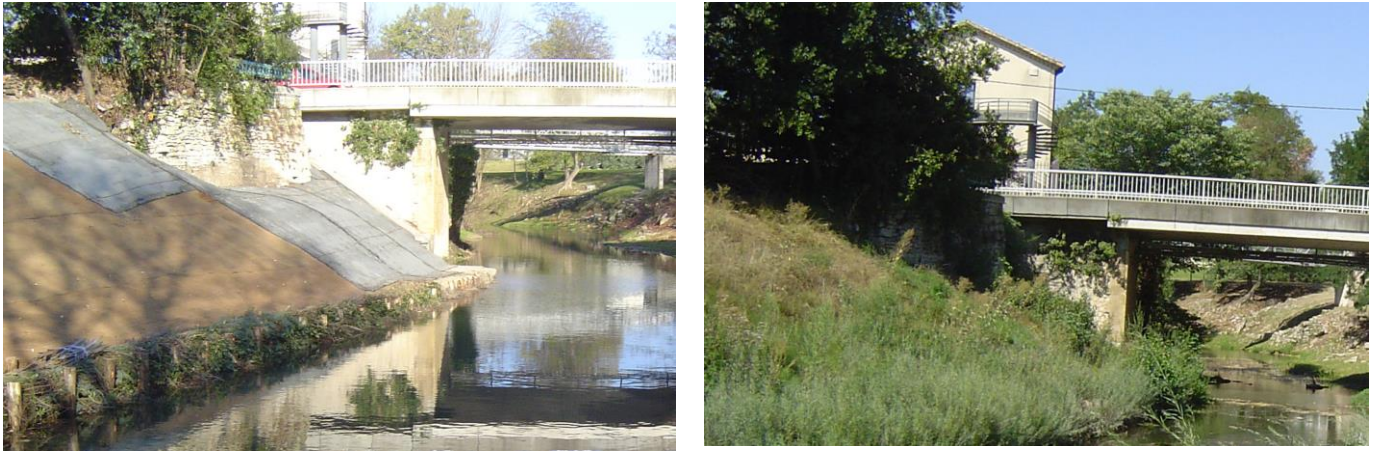
Figure 5. Restauration des berges de l'Alzon au Pont des Charrettes - Uzès (30)
