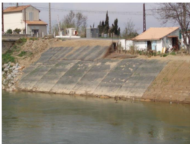
Mise en œuvre en 2006
