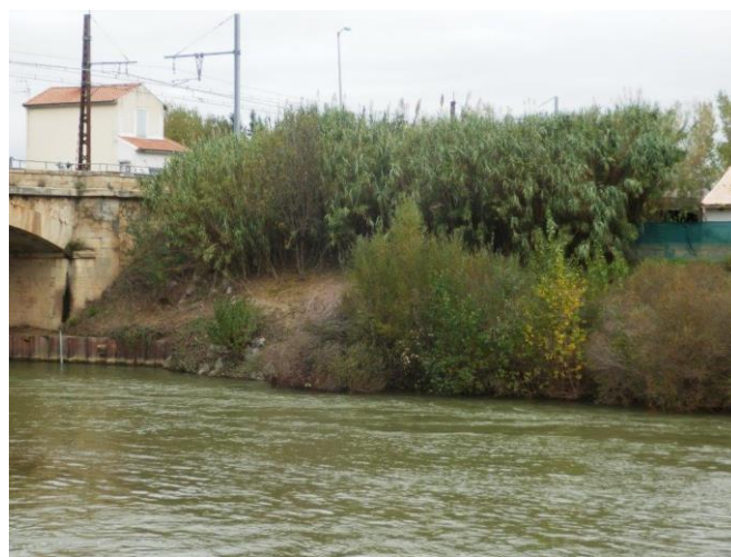
Après la crue du 15 octobre 2018
